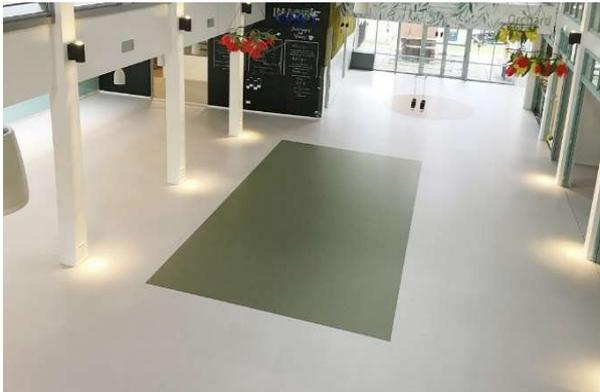
**Ndurance** ist ein innovativer, fugenloser Kautschuk-Bodenbelag aus rein natürlichem Biopolymer und bis zu 50 Prozent recyceltem Gummi. Zusammen mit natürlichen Farbpigmenten gestaltet dieser die dezente Musterung und Optik des Belags, welcher durch die Verarbeitung ohne unterbrechende Fugen hohen ästhetischen und hygienischen Ansprüchen gerecht wird. Das flexible Material sorgt für ein wohlig weiches Laufgefühl und verliert auch nach langer Zeit seine positiven Eigenschaften nicht.
